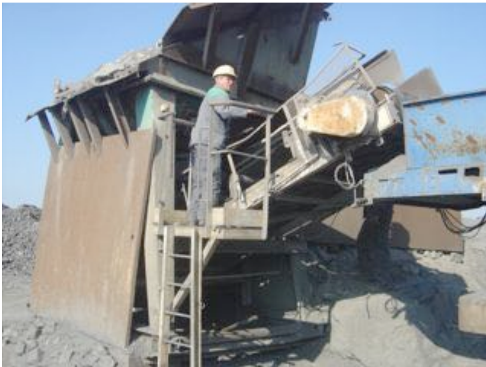
Vue de l'installation de criblage en marche.
