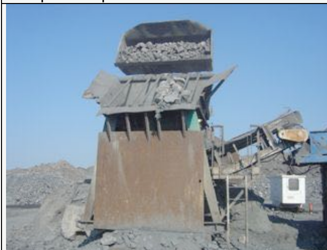
Chargement trémie à l'aide du chargeur.
