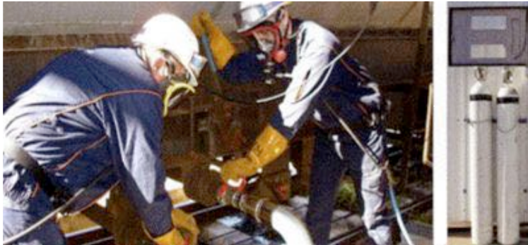
Poste de chargement assaini.
