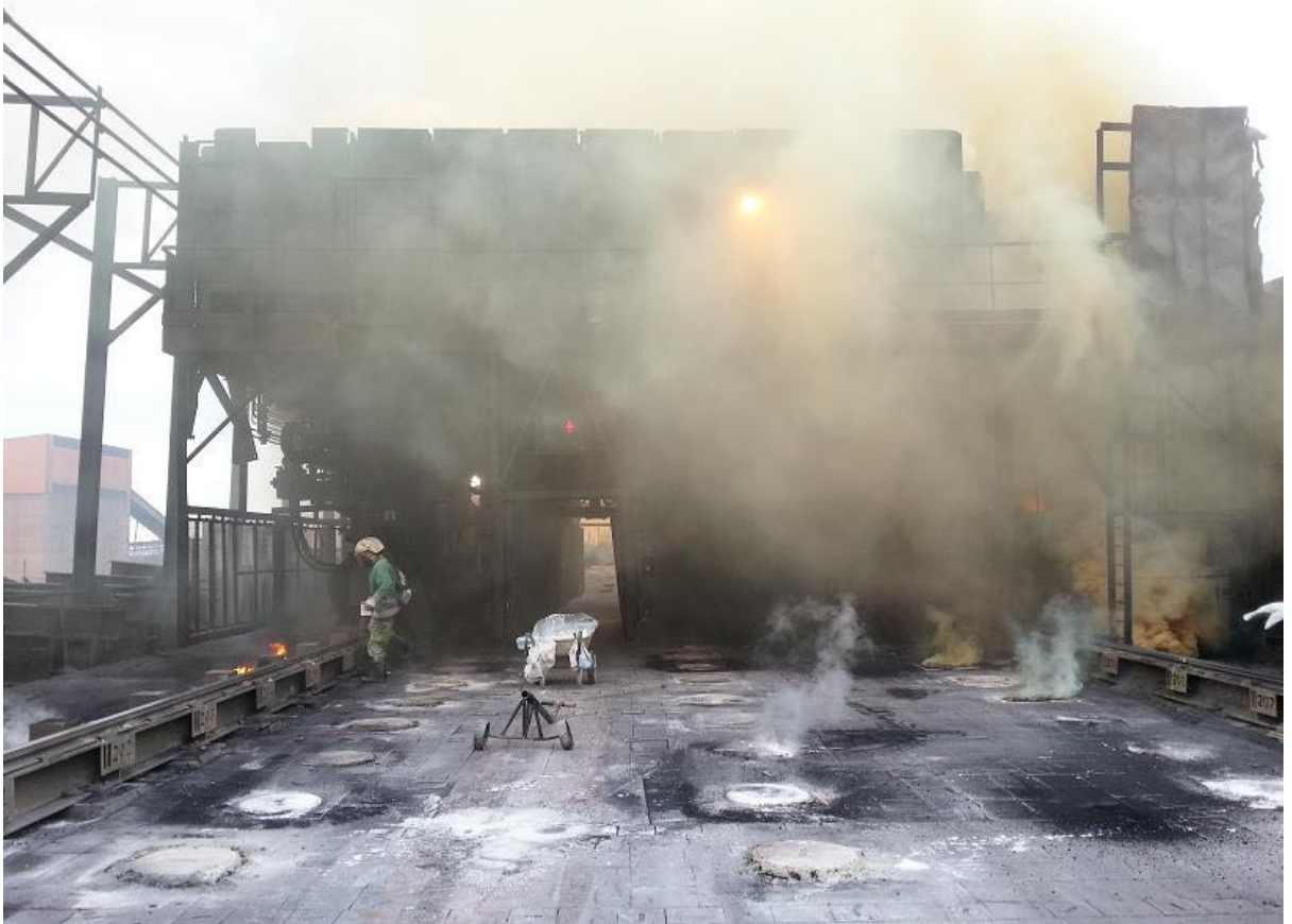
Cokerie, photo du plancher d'enfournement (2012).
