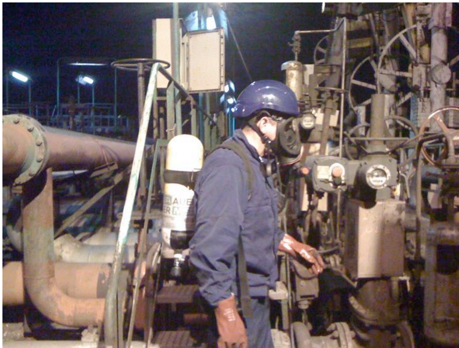
Poste de chargement de produits pétroliers exposant au benzène : opérateur équipé d'un ARI (en équipement individuel seulement depuis 2003).
